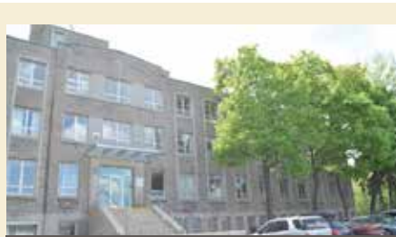
La façade du pavillon Masson. Source : BMAA
