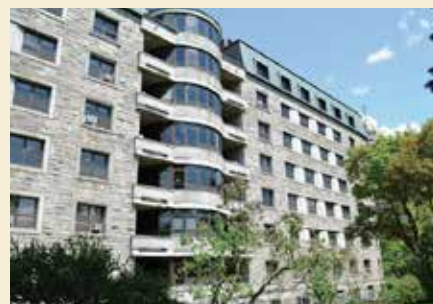
Le pavillon Le Royer, façade donnant dans le jardin des RHSJ. Source : BMAA
