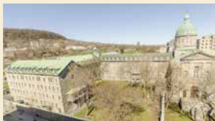
L'aile du généralat à gauche se fond à l'ensemble conventuel. Source : BMAA
