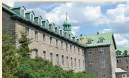
L'architecture traditionnelle religieuse du premier ensemble, façade ouest du couvent. En avant plan, l'agrandissement de 1931 qui épouse l'architecture de Bourgeau. Source : BMAA
